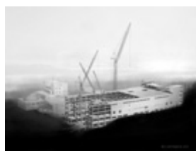
「某建物工事中」
